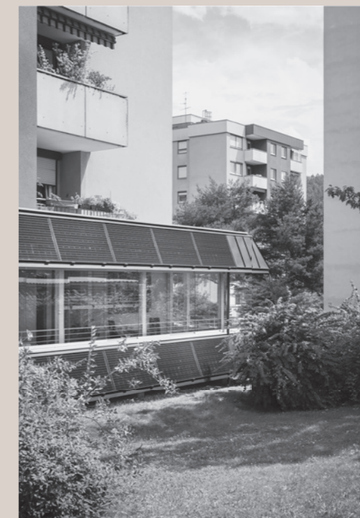
Außenansicht der installierten Demonstrationsanlage zur Veranschaulichung der erforschten thermischen Sanierungsmethode | Exterior view of the demonstration unit installed in summer 2017 to illustrate the researched thermal restoration method © Alexander Gebetsroither
